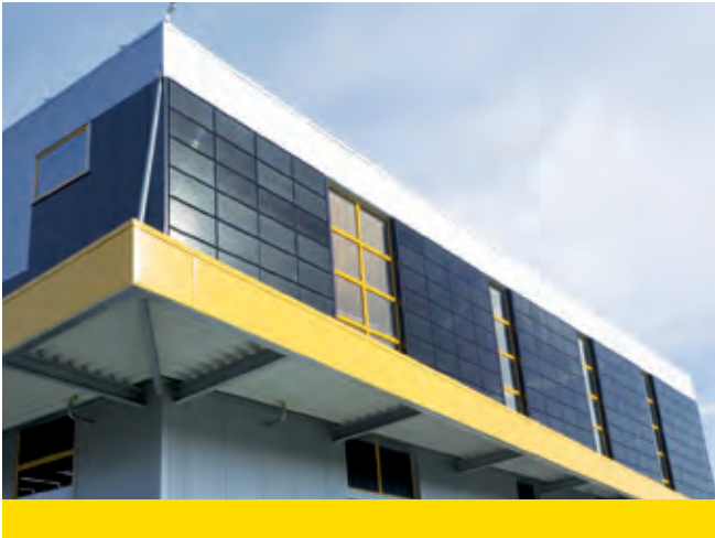
Fassadenintegrierte Module an der Industriehalle der Firma Heuchemer in Miehlen (Planung: Goldbeck Bau)
