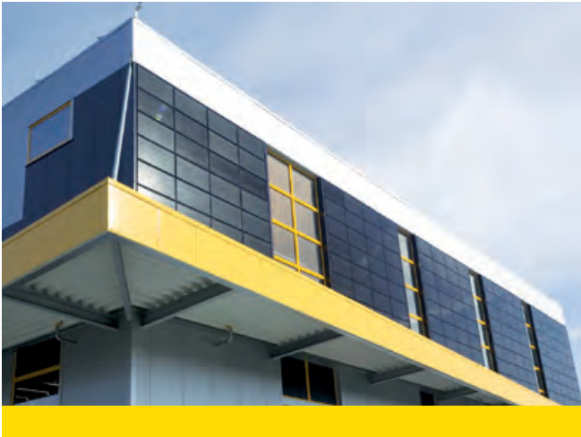
Modules intégrés à la façade du hangar industriel de la société Heuchemer GmbH und Co. KG (à Miehlen/Taunus, Conception: Goldbeck Bau)
